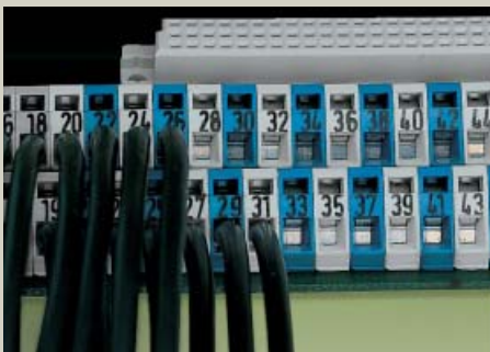
Размещение колодок в шахматном порядке
